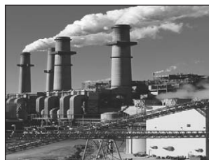
Planta generadora de energía eléctrica
